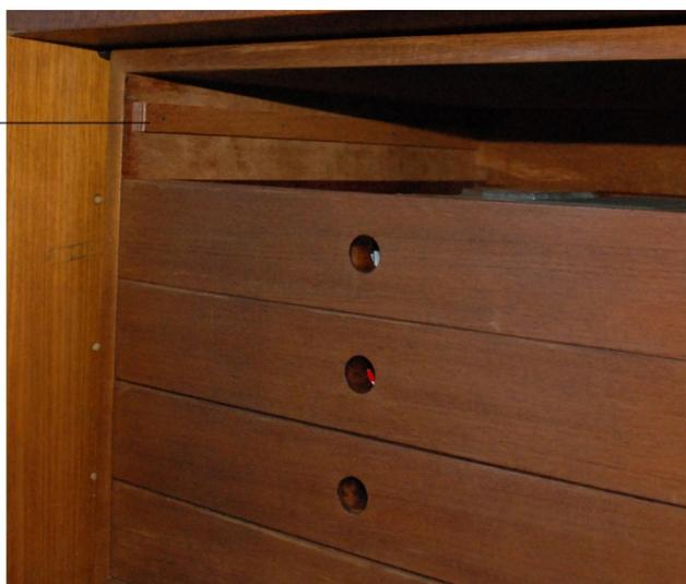
**FIG 49** – Gaveteiro com guias laterais. Notar ausência de barras entre as gavetas.
