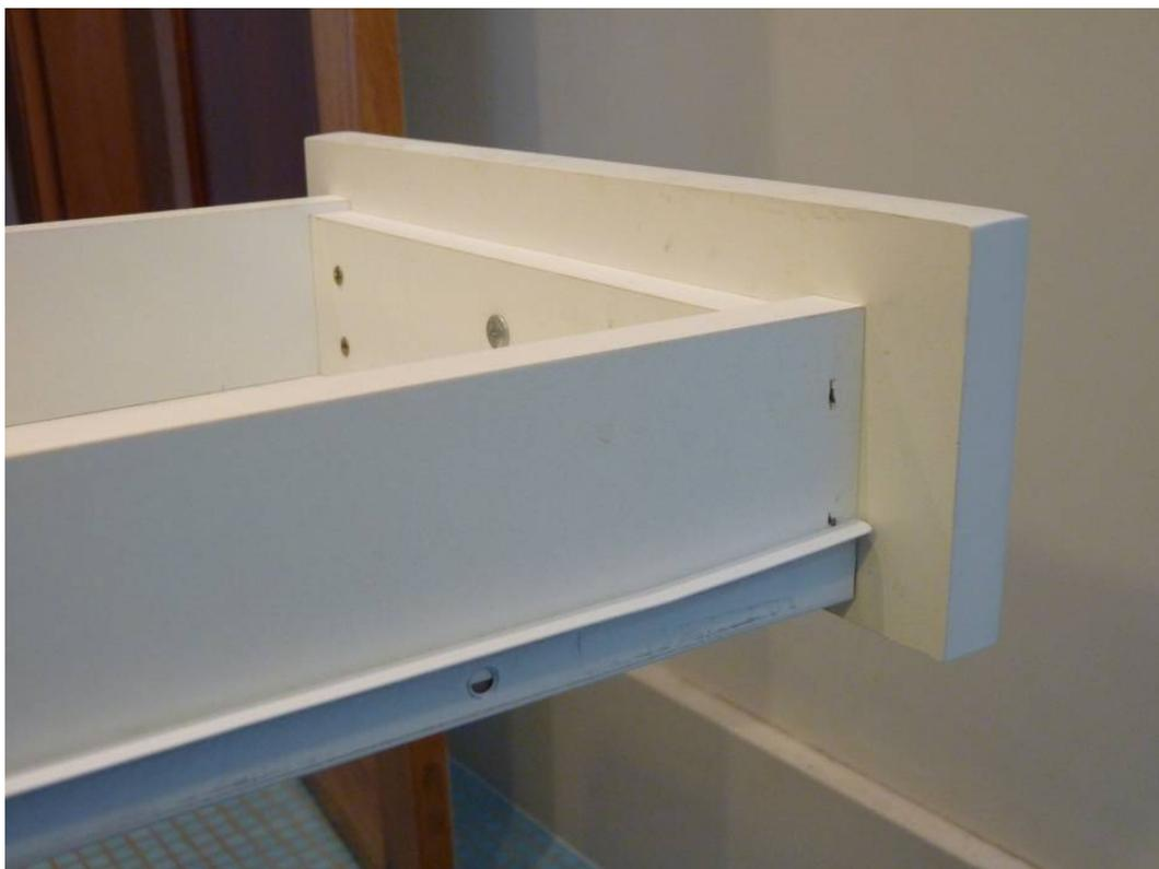
**FIG 76** – A corrediça metálica esconde e dá acabamento ao topo da chapa de MDF que conforma o fundo da gaveta.
