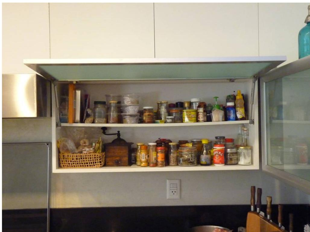
**FIG 78** – Notar a flexão da prateleira superior apoiada apenas nos extremos. Notar, também, a pequena carga a que ela está submetida.
