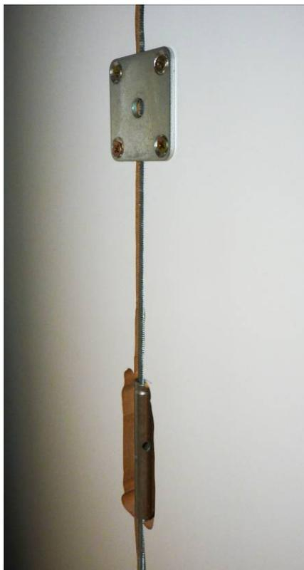
**FIG 79** – Esticador de portas de armários. A maneira grosseira da instalação deste exemplo é decorrente do fato de o esticador ter sido instalado para corrigir o problema e não para preveni-lo.
