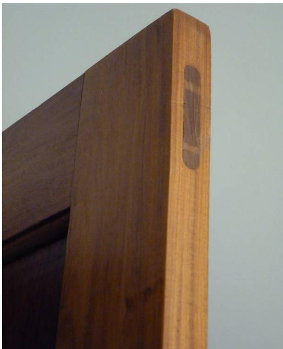
**FIG 6** – Respiga passante em topo de porta. Notar os dois encunhamentos de cor mais clara no topo da respiga.
