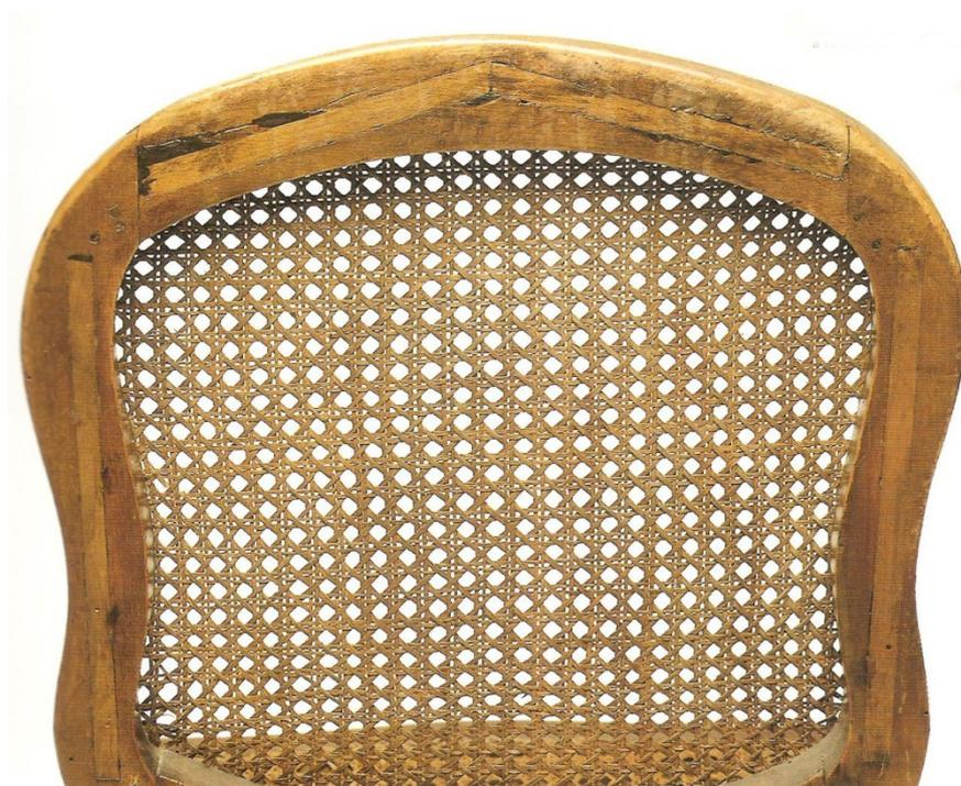
**FIG 10** – Por vezes o desejo de dar acabamento piora o resultado final. Nas costas desta cadeira, as taliscas de madeira que escondem a furação de fixação da palhinha resultaram em um acabamento inferior que a própria exibição dos furos.
