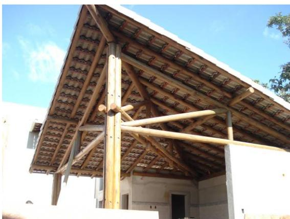
**FIG 3a** – Obra construída com estrutura de eucalipto retificado.
