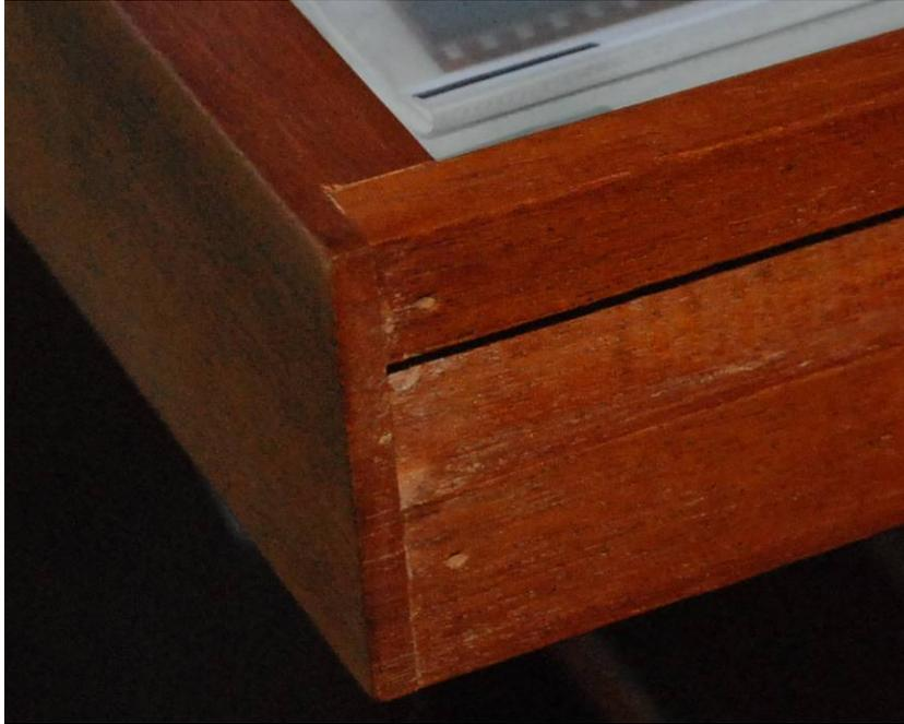
**FIG 51** – Quina frontal de gaveta exibindo união em meia madeira da lateral com a frente da gaveta.
