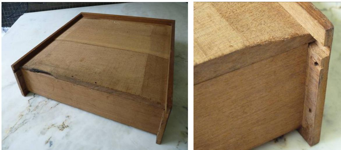
**FIG 50** – Visão do plano inferior de gaveta antiga. Notar o chanfrado das tábuas do fundo para adequar sua espessura à largura do rasgo das laterais.
