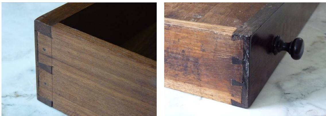
**FIG 53** – Quina frontal de gaveta com união em malhete embutido tipo rabo de andorinha.
