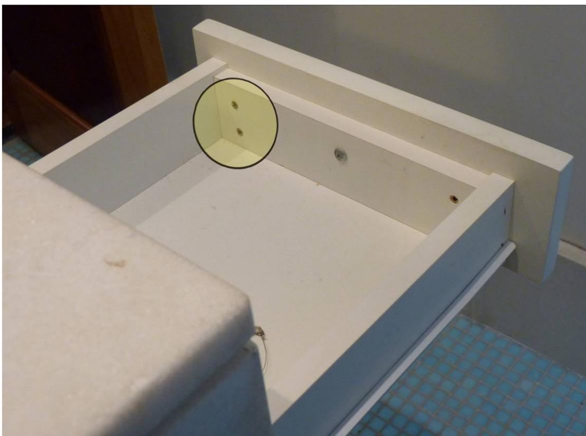
**FIG 75** – A frente da gaveta é independente do corpo da mesma. Notar parafusos fixando-a de dentro para fora.
